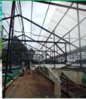
Installing the new roof ការដំឡើងដំបូលថ្មី
